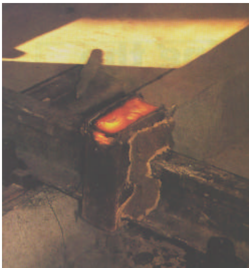
Figura 6 – Processo de soldagem aluminotérmica.
